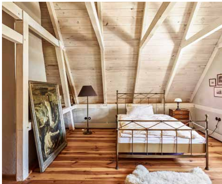
Innen sind die Sparren und Dachschalungsbretter des Satteldaches sichtbar und wurden lediglich mit einer Kalk-Kaseinlasur gestrichen.
