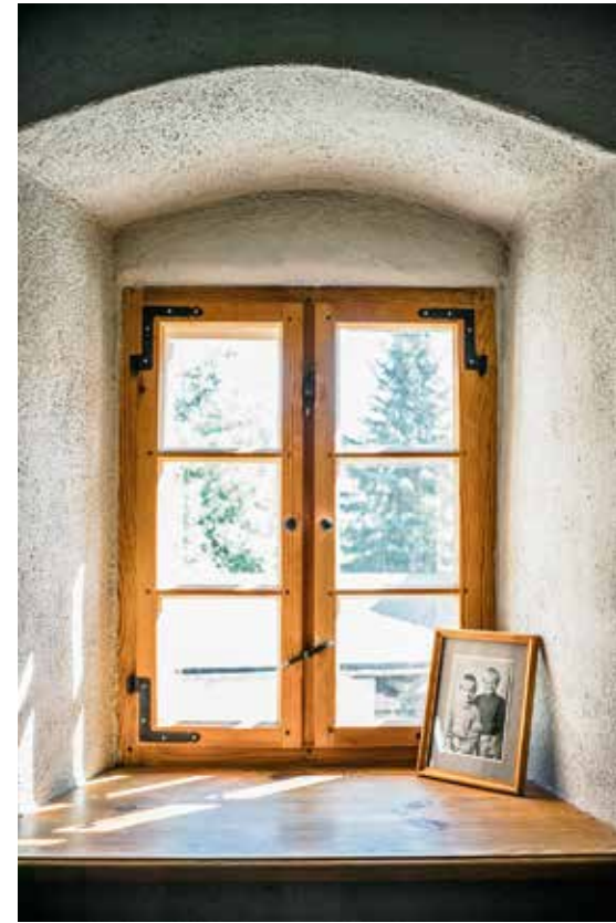
Im Obergeschoss wurden passende Holzfenster nach alter Manier gebaut: Mit glasteilenden Sprossen und Holznutleisten, um die Scheiben zu befestigen.
